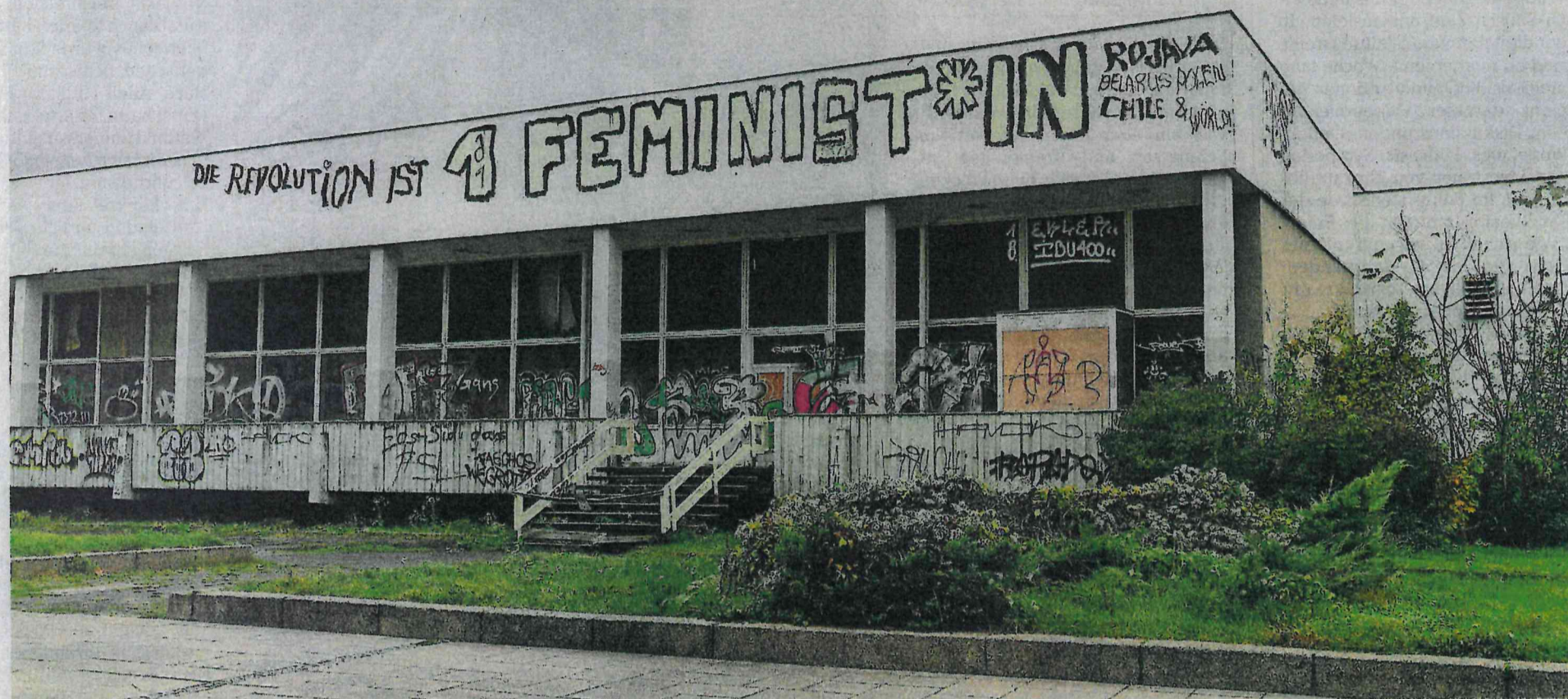
Ein Zustand, der keiner ist: die Robotron-Kantine, Dresdens noch ziemlich geschundener Ostmoderne-Kasten.
